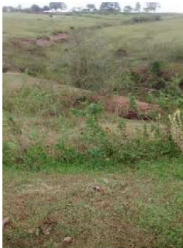
Imagem 3: Ponto de lançamento das águas pluviais na sub-bacia 1 (Ribeirão dos Macacos)
