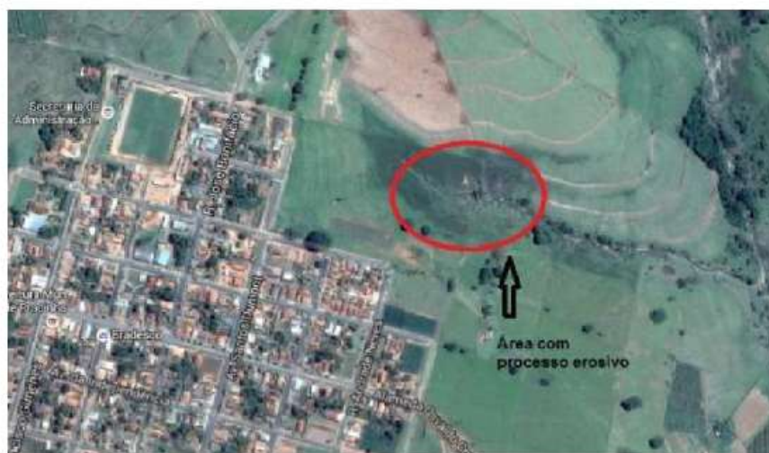
Figura 22: Área degradada pelo lançamento de águas pluviais, na sub-bacia 1 (Ribeirão dos Macacos)
