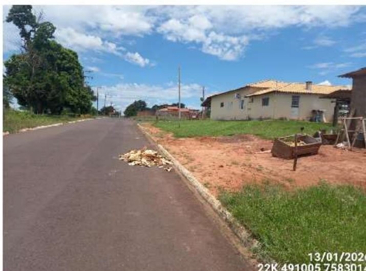
Imagem 5: Pequena pilha com restos de telhas para coleta da Prefeitura Municipal
