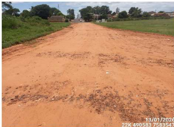
Imagem 13: Trecho de estrada rural com aplicação do RCC reaproveitado
