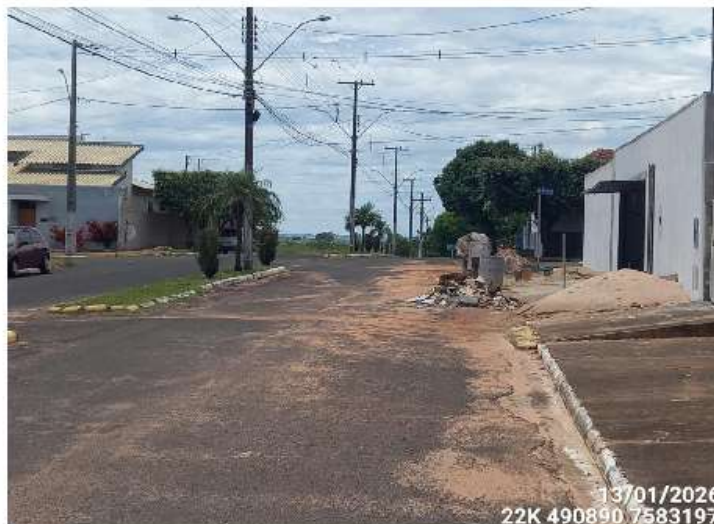
Imagem 4: Reforma residencial com pilha de materiais dispostos na via pública
