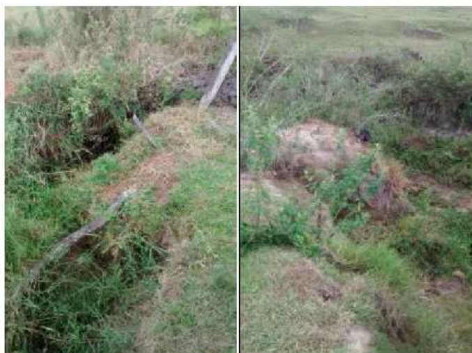
Imagem 4: Ponto de lançamento das águas pluviais na sub-bacia 1 (Ribeirão dos Macacos)
