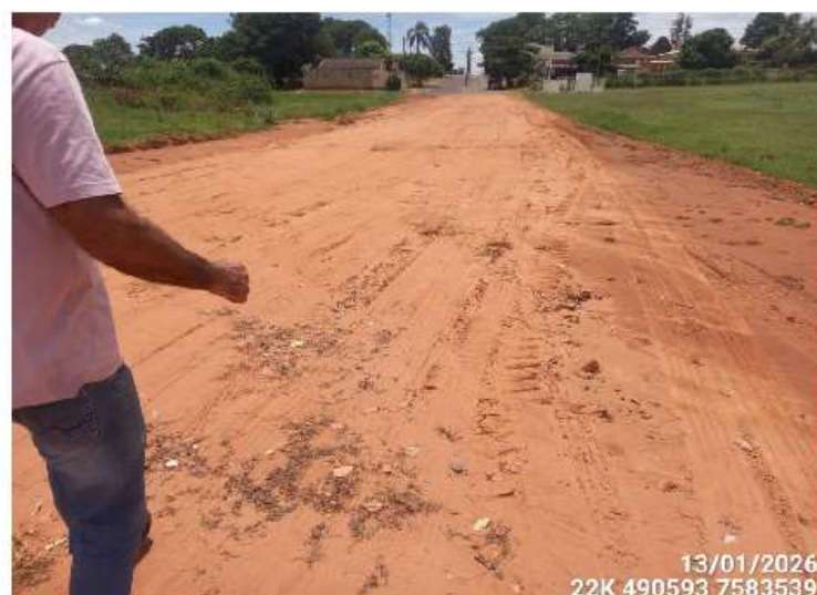
Imagem 14: Trecho de estrada rural com aplicação de RCC recuperado
