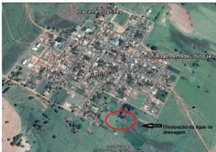
Figura 21: Área degradada pelo lançamento de águas pluviais, na sub-bacia 2 (Ribeirão dos Macacos)
