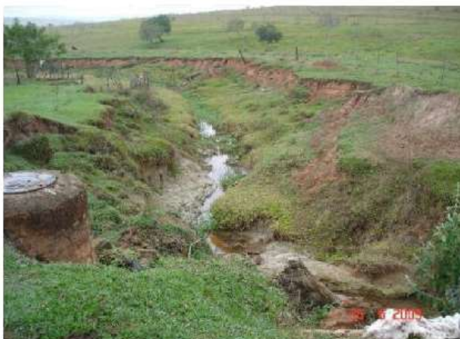
Imagem 1: Ponto de lançamento, em 2009, das águas pluviais na sub-bacia 2 (Ribeirão dos Macacos)
